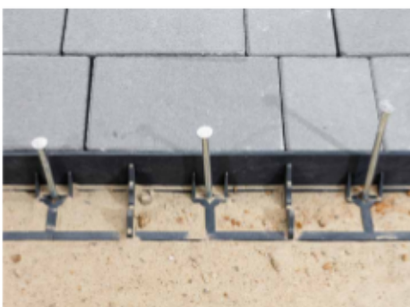
Obrzeże przy kostce brukowej
